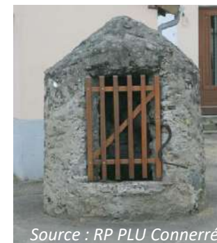
Puits à mitre, Connerré
