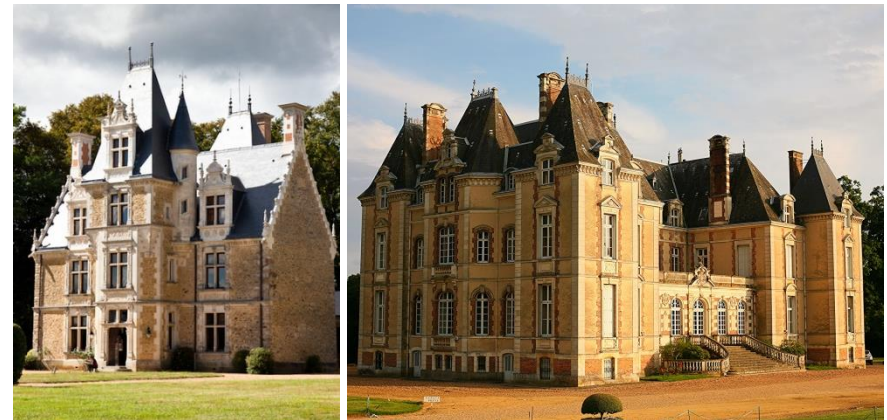
Manoir du Bois-Doublé à Saint-Célerin (gauche) / Château de la Pierre à Coudrecieux (droite)
